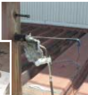
写真2 【水分の測定】 排ガス中の水分を測る
